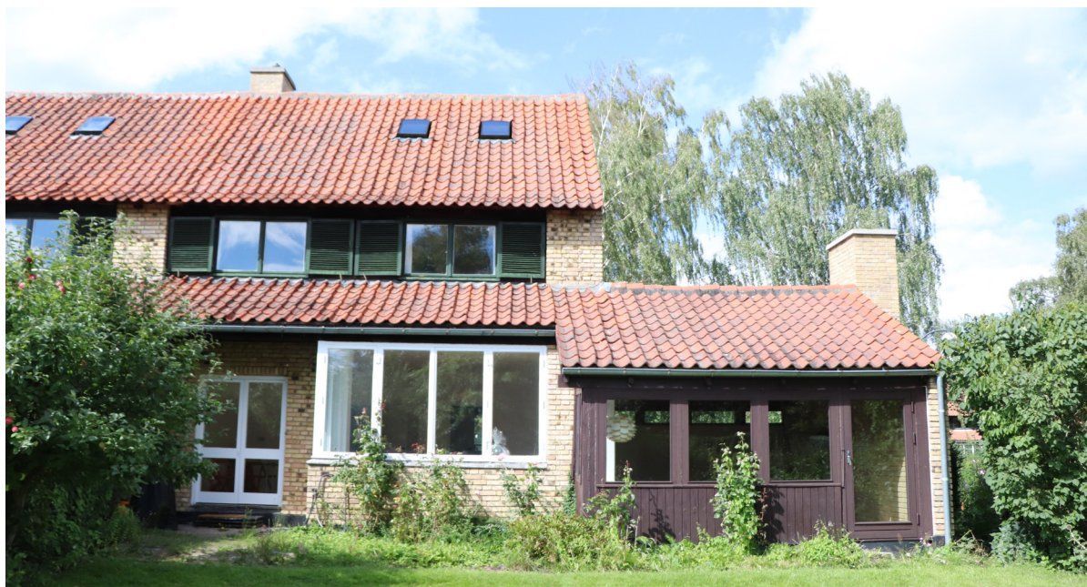
Øverst: Indgangsfacade Granholmen 29 (plads 6)
